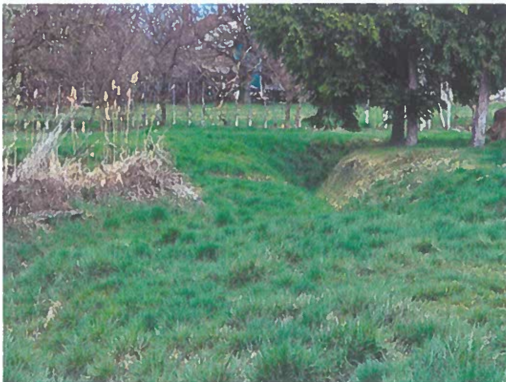
659 hrsz induló csapadékvíz-elvezetés nyílt árka
